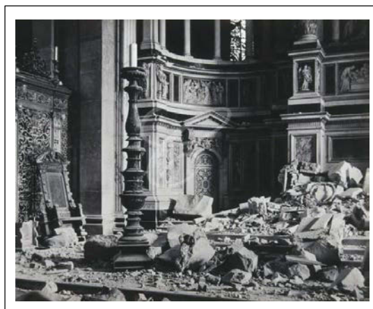
Лондон. Разрушенный собор Св. Павла. 1941 г.
