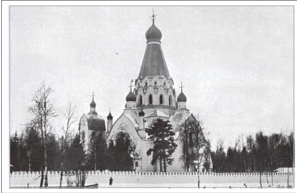
Церковь святых апостолов Петра и Павла на Пороховых заводах близ Шлиссельбурга. Архитектор В.А. Покровский. Вид с северо-востока. Фото 1907.
