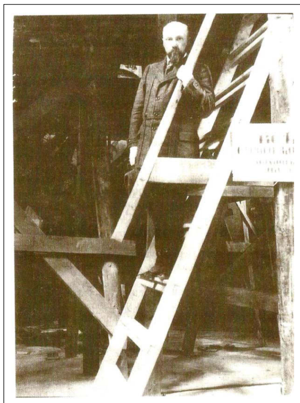
Н.К. Рерих на лесах абсиды строящегося храма Св. Духа в Талашкине. (Фото 1910 г.)
