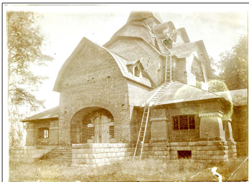
Строительство храма св. Духа в Талашкино. (фото: ОР ГТГ, ф. 44. д. 1694.)
